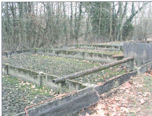
Fig. 4-c : STEP de Montoz : cheminées d'aérations des installations
